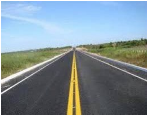
Estrada aberta ao tráfico
